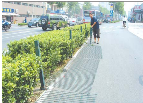
14日,一名工人正在拆除绿化带护栏。本报记者 赵伟 摄
