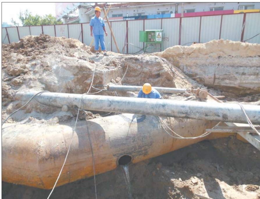
济齐路输水管道迁移施工现场。 本报记者 蒋龙龙 摄
