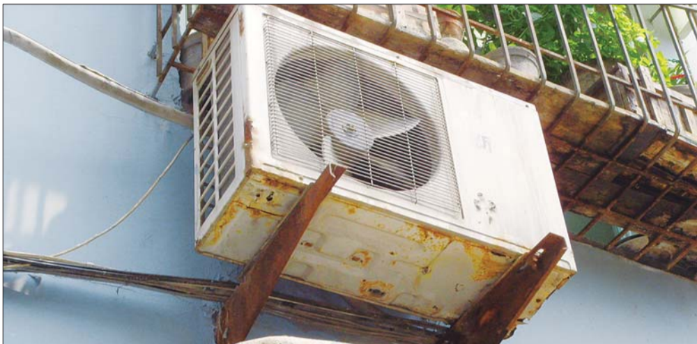
在济南不少老小区,生锈的空调外机支架随处可见。 本报记者 赵伟 摄
