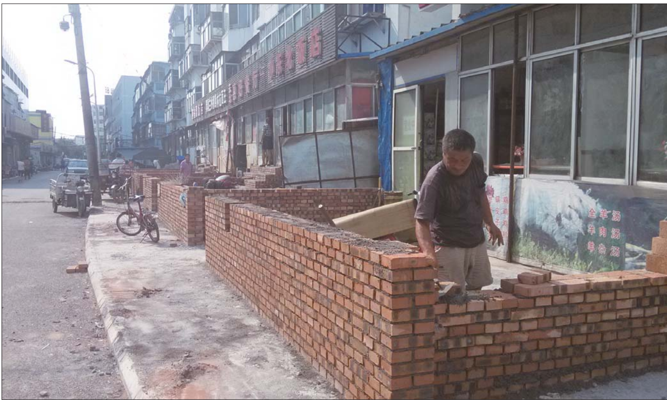
张店安乐街改造施工现场，工人正在搭建封闭的室内摊位。 本报见习记者 唐宁 摄
