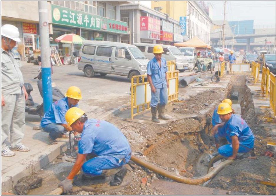
正在施工的北关北路片区供水管网改造工程。 本报记者 蒋龙龙 摄
