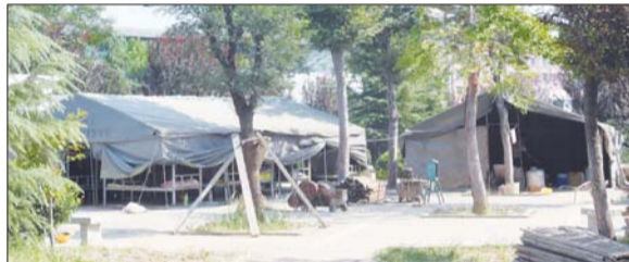
十六里河一处小花园被建筑工人搭建的帐篷所占。 蒋龙龙 摄
