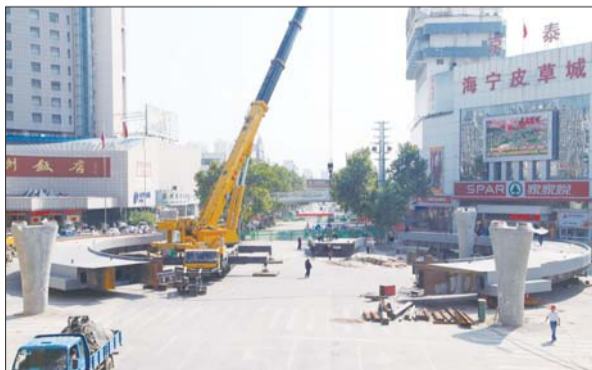
“环形天桥”正在施工。本报记者 张冬梅 摄
