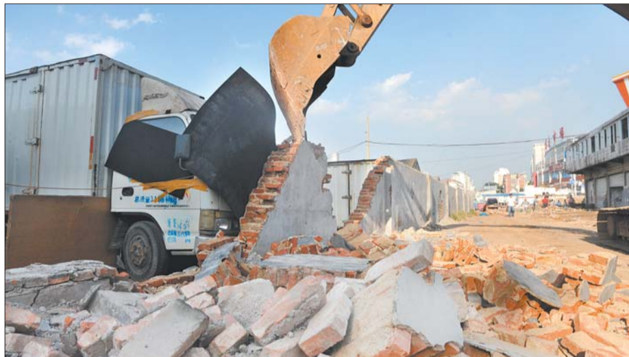
一辆挖掘机停在拆墙现场,但司机不见踪影。 本报记者 张中 摄
