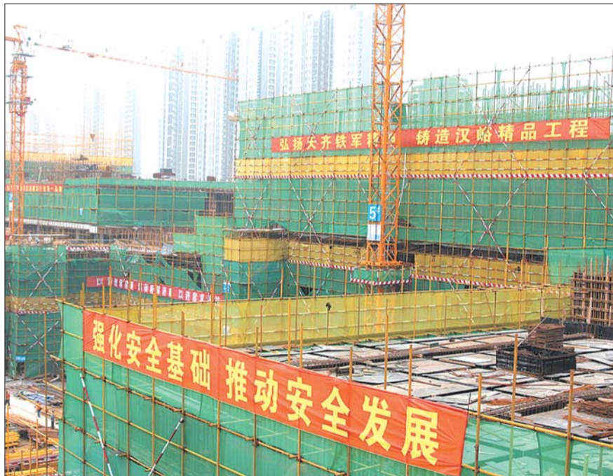
汉峪金谷工程现场。 本报通讯员 王敏 摄
