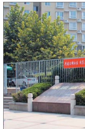
小区门口已经安装上铁栅栏,业主需刷卡进入。
