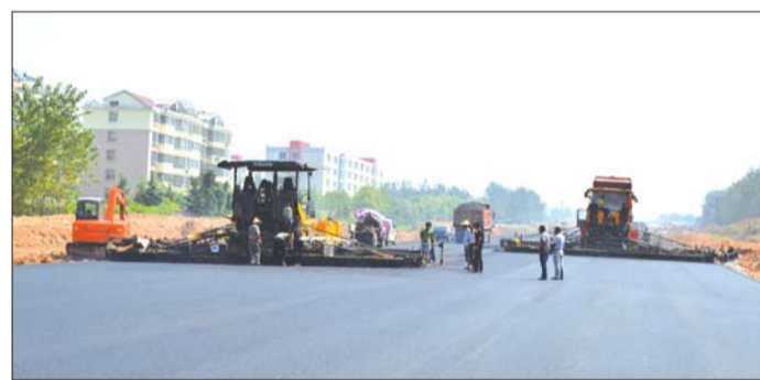
两台摊铺机在铺设沥青。本报记者 王伟强 摄
