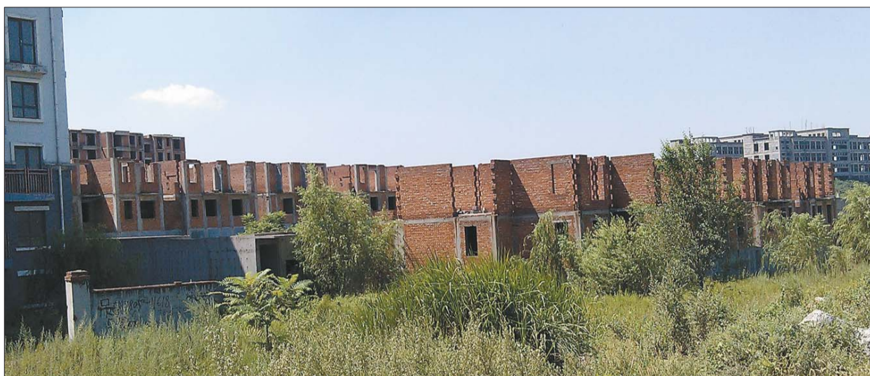
8月31日,烂尾已经5年的彩石山庄项目一片荒芜。 本报记者 李岩侠 摄
