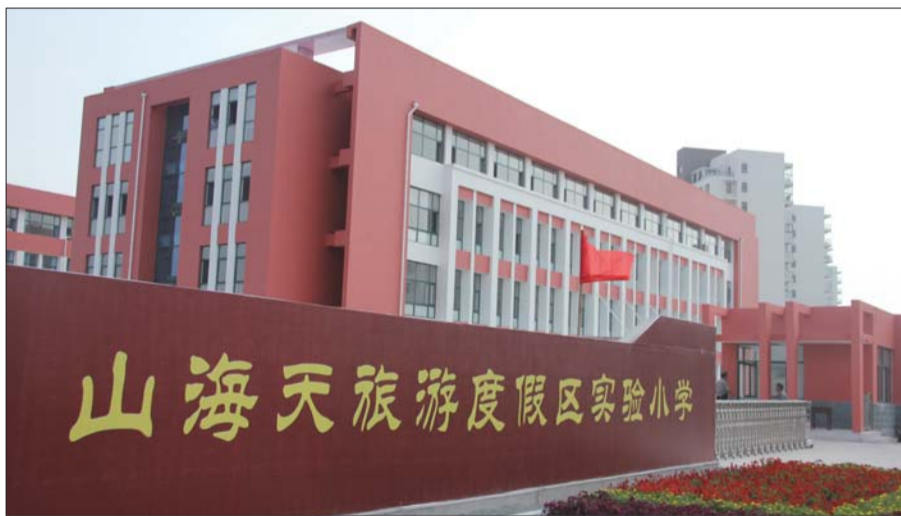
山海天旅游度假区实验小学已完工。见习记者 许妍 摄
