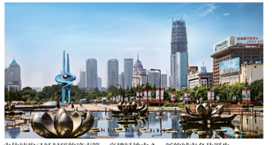
主体结构已经封顶的济南第一高楼绿地中心，新的城市名片诞生。
