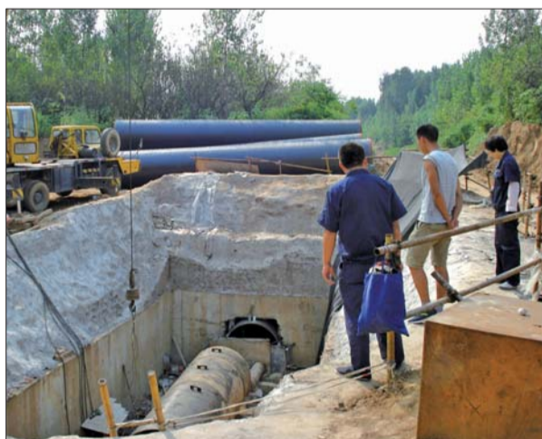
庞锦(右一)在“南水北调”长清段施工现场。
