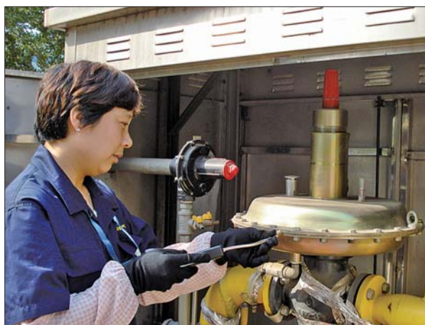
庞锦用测漏仪检测调气室。
