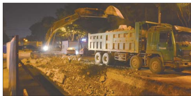
道路深夜还在施工,以后挖路要预留燃气管道的位置。(资料片)
