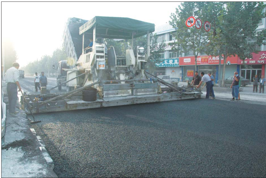
①12日下午4点半,县南环东路沥青摊铺施工开始。
