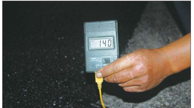
③12日晚上10点半,沥青摊铺温度高达140℃,还散发出刺鼻的气味。
