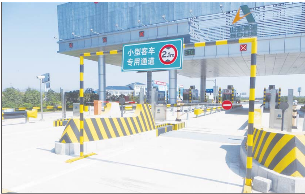
枣临高速峰城南站设置了限高杆。本报记者 刘婷婷 本报通讯员 周猛 摄
