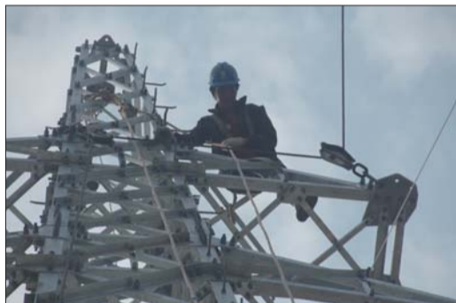
正在高空作业的保电工人。
