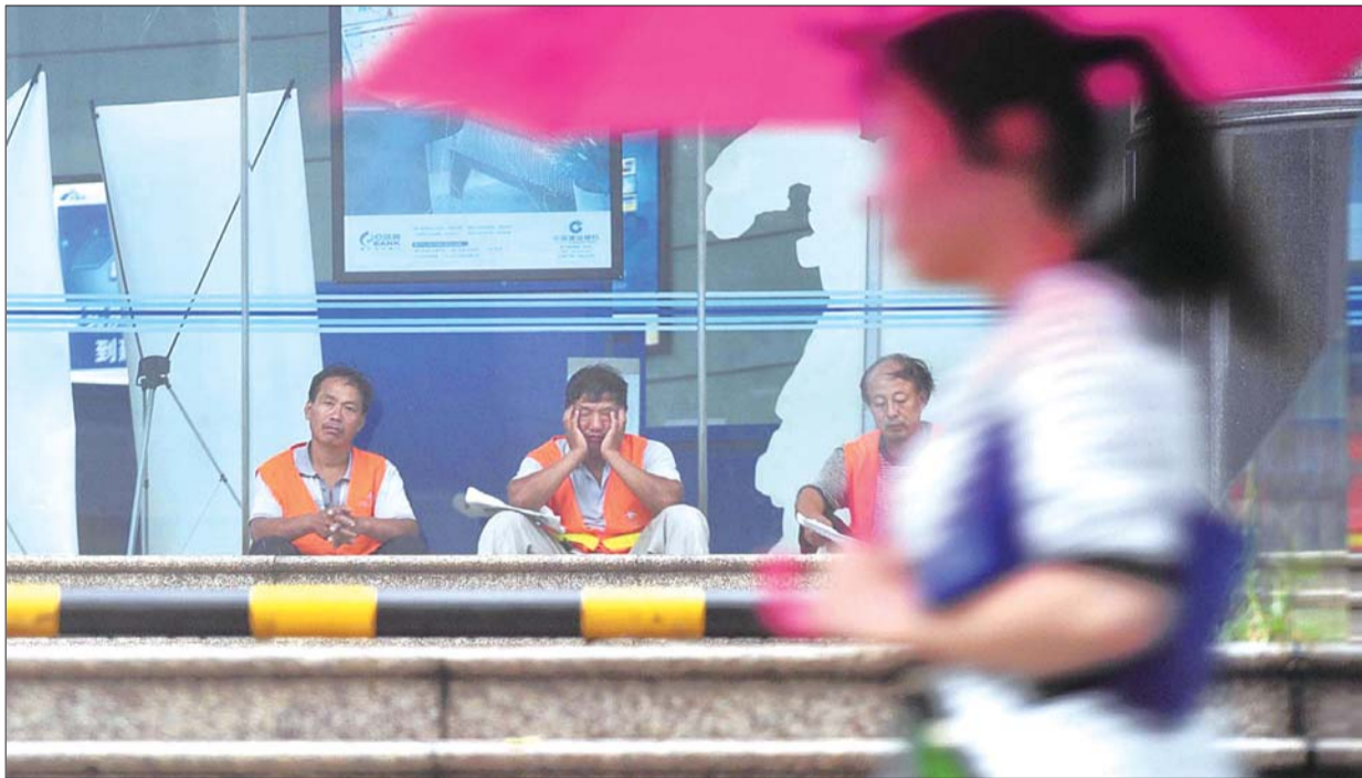
21日,在济南泺源大街,在非机动车道上施工的工人们在路边的银行门外避雨。当日下午济南下起一场急雨,假期期间依然劳作的工人们在避雨的同时得到暂时的休息。
