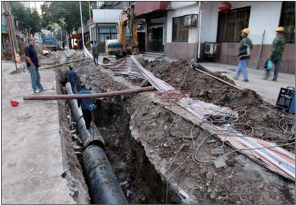
商园社区热水管网施工改造现场。 本报记者 王鑫 摄
