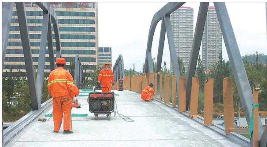
奥体中路正在施工的过街天桥今年10月就能投入使用。
