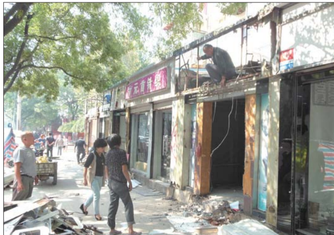
和平路沿线门头房开始拆迁。 本报记者 蒋龙龙 摄
