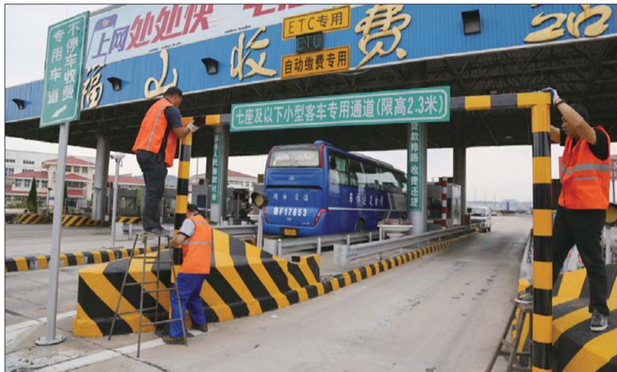
在福山收费站,工作人员正在安装龙门架。本报记者 孙健 摄
