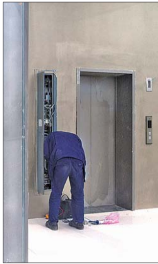
工作人员正在对电梯进行维护调整。 本报记者 陈玮 摄
