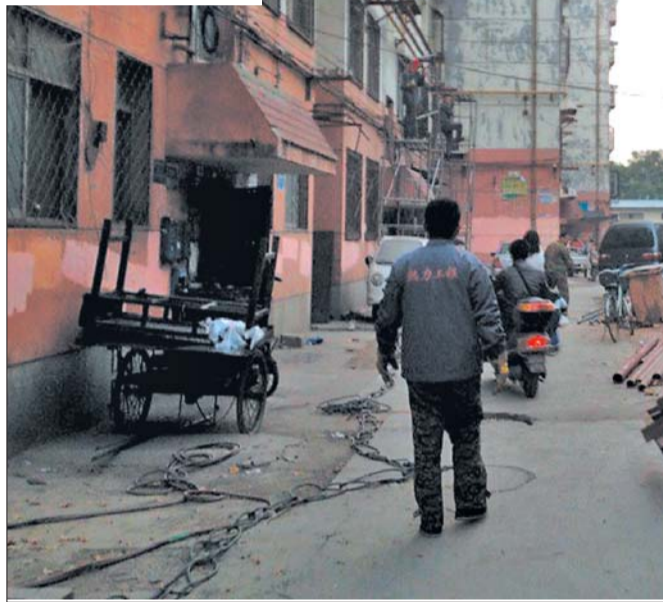
11日下午,南全福小区西区正在铺设暖气管道。
