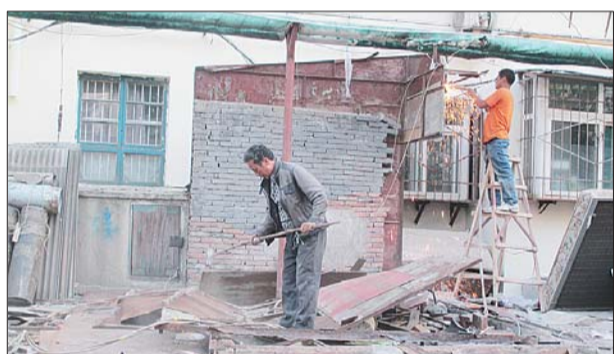
11日,施工人员对一间铁皮屋进行拆除。本报记者 肖龙凤 摄
