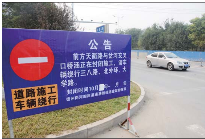
天衢路岔河桥实施封闭。本报记者 马志勇 王小会 摄影报道
