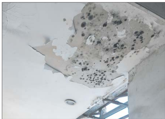
没钱整修,塑料公司的办公地点比较破旧。本报记者 左庆 摄
