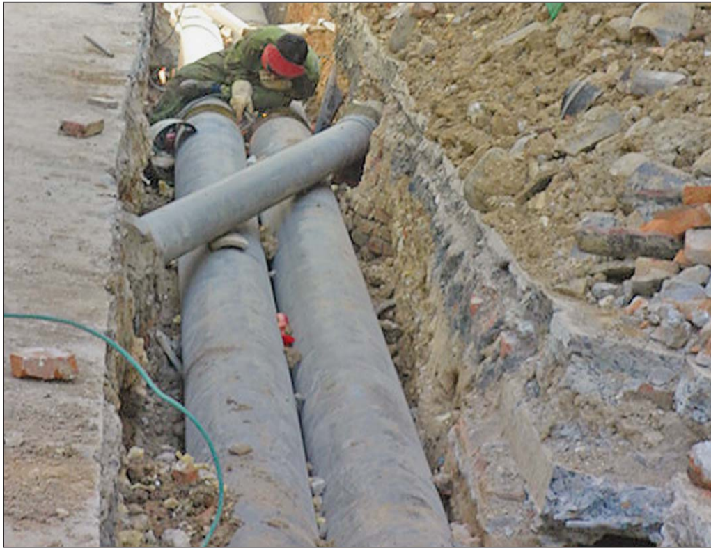
对二级管网进行检测。 本报见习记者 赵克 摄
