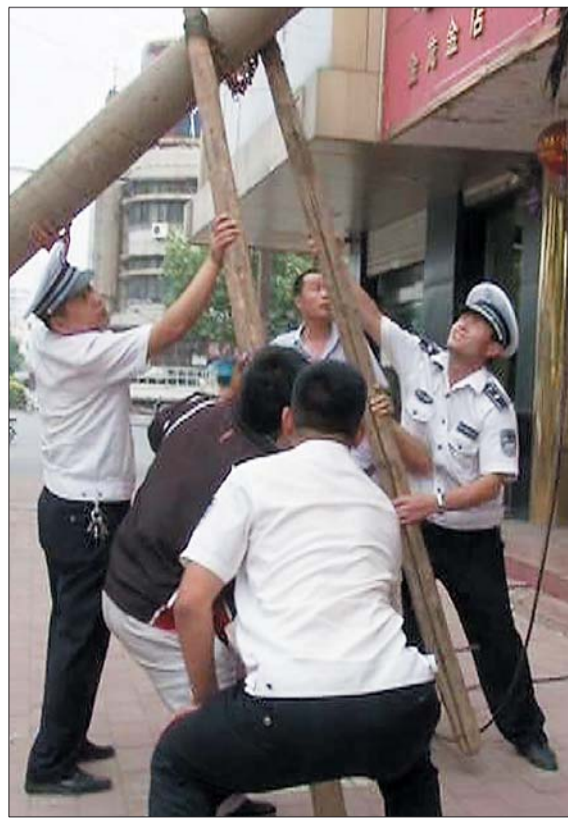
执法人员拆除废弃电线杆。
