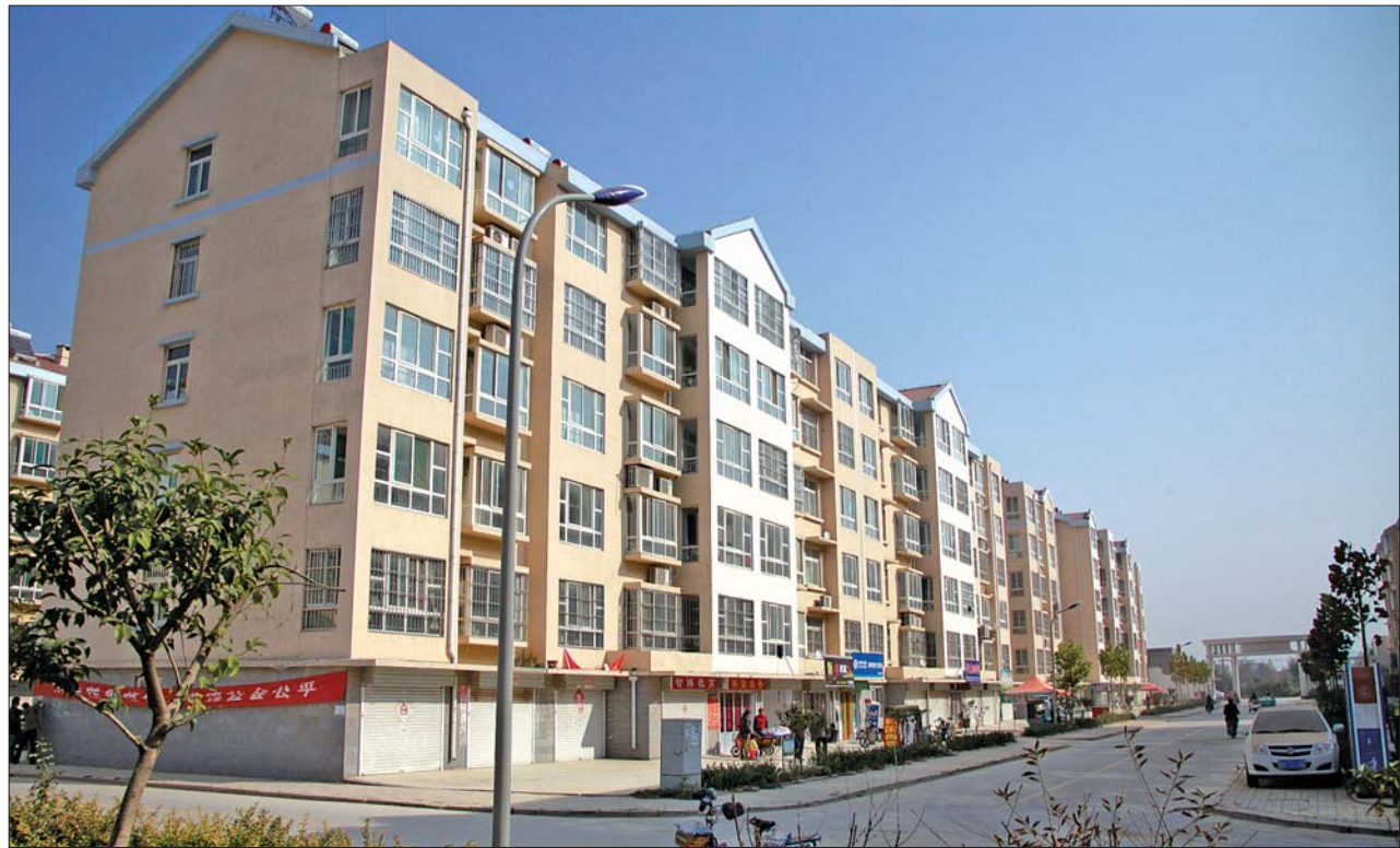
一栋栋楼房拔地而起。见习记者 杨磊 摄
