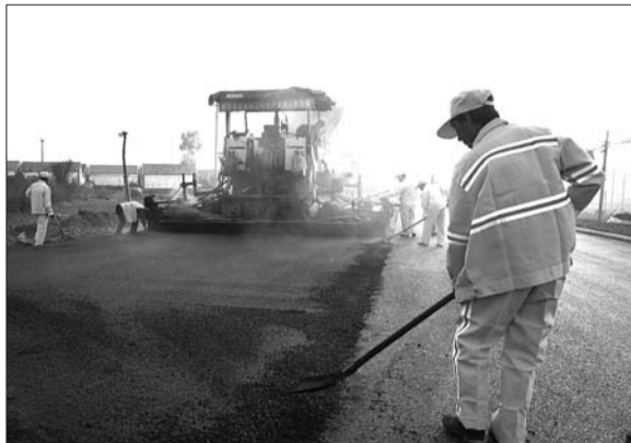
225省道路面维修工程正在进行的沥青路面摊铺。
