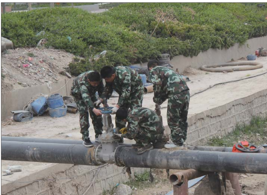
工作人员正在检查供热设备。
