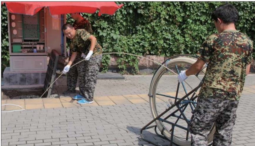
淄博移动的施工人员正在冒着酷暑铺设光纤电缆。(资料片)
