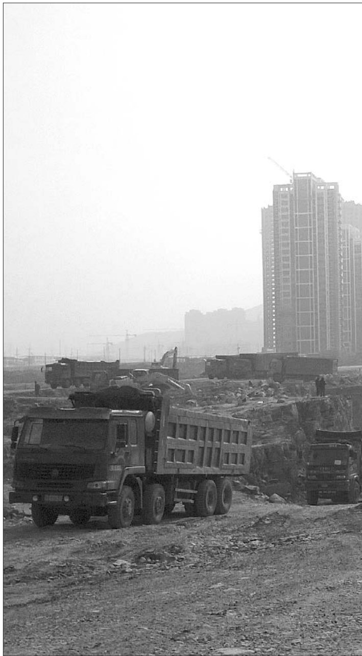
14日,济南汉峪金谷施工现场尘土飞扬。见习记者 魏新丽 摄
