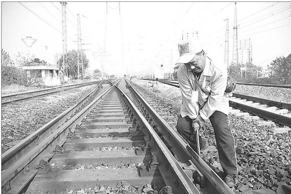
▲螺丝松动,工人将螺丝拧紧。
