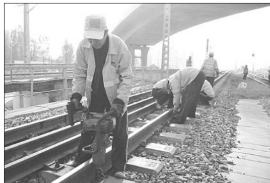
▲为铁轨做细微的调整,误差不允许超过1毫米。
