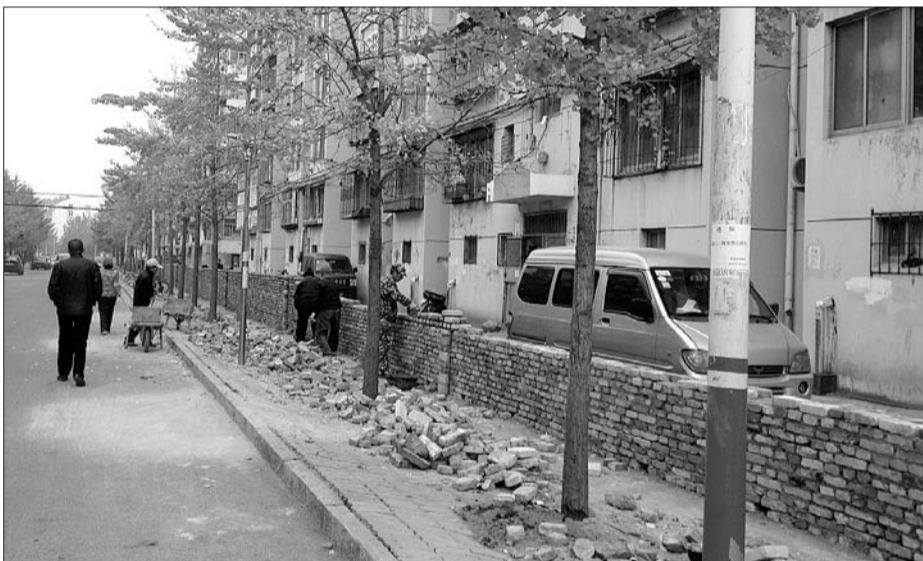
14日下午,工人正在福泰社区外砌围墙。 本报记者 杨薪薪 摄
