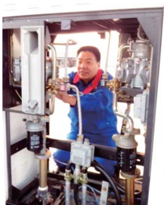
中石化东港片区 62 站站站长崔慎国在维修和检修设备。
