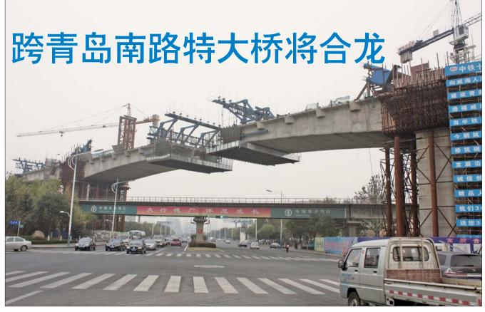
横跨青岛南路的青烟威城铁特大桥即将合龙,14日,桥体上侧弧形系杆拱已开始安装,跨青岛南路特大桥主跨在本月底完成合龙。青烟威城际铁路的通车后,青岛、烟台、威海间将真正实现1小时生活圈,实现相邻城市的"同城效应"。据悉,青烟威城际铁路有望明年6月试跑,明年年底实现全线通车。
