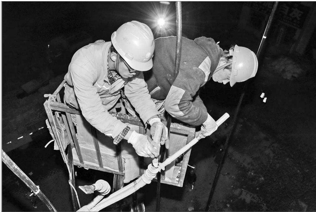
13日傍晚6时30分许,乳山供电公司施工人员加班加点进行35千伏华都I线、华都II线电缆接弧。当日,为保证居民用电,工作人员用一天时间就完成6条35千伏电缆和2条10千伏电缆敷设任务。
