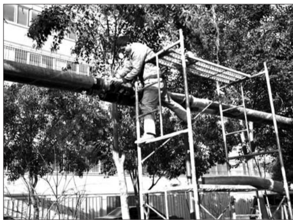
中武新苑小区,维修人员正在检查除污器。 公素云 摄
