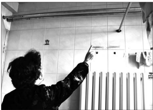
仙营南组团小区,居民家中管道一半热、一半凉。 公素云 摄
