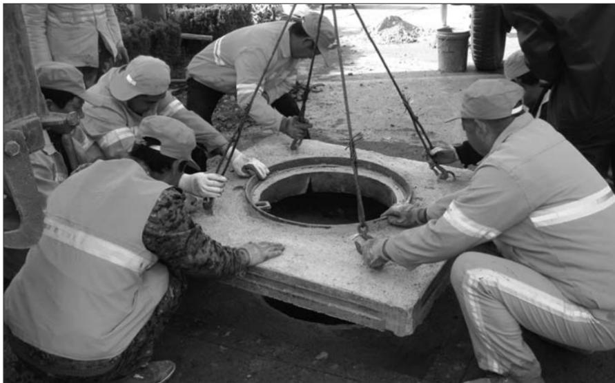
15日,在潍坊市胜利街上,养护人员正在更换窞井井盖。以前使用的井盖在经过车辆不断碾压后会出现下沉的情况,车辆经过时会有颠簸感,此次更换的新井盖,底座为一个1平方米左右13厘米厚的混凝土。更换这种井盖后就不会出现高低不平的情况。
