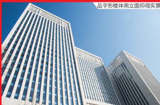
品字形楼体南立面仰视实景
