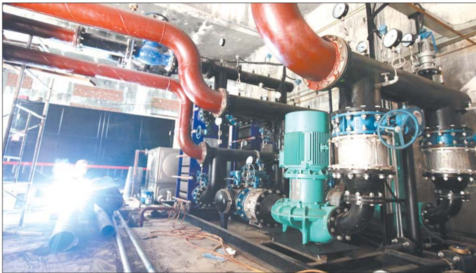
供热季前,济南热电正在对小区锅炉房进行煤改气。 本报记者 蒋龙龙 摄
