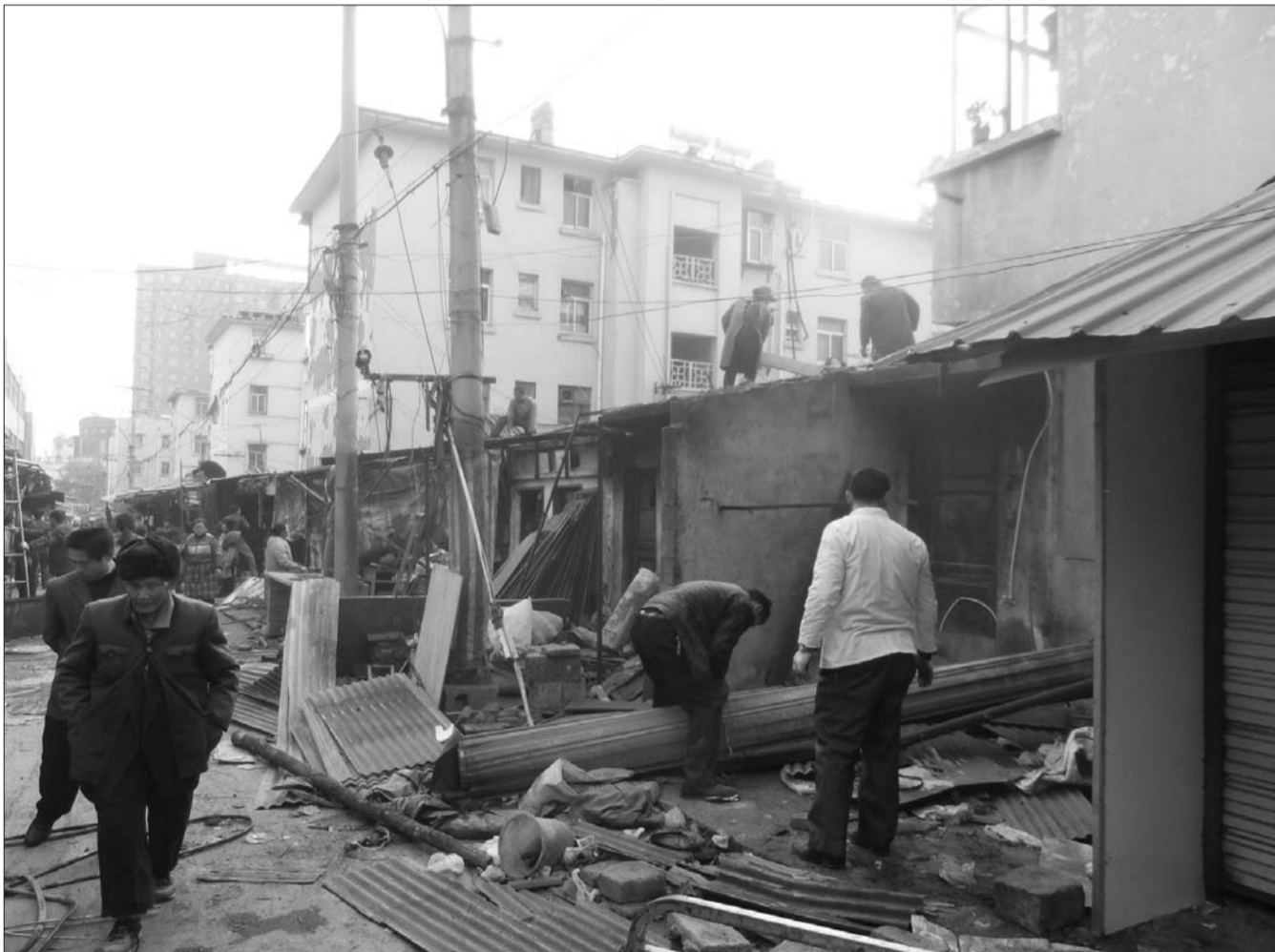
商铺业主正在拆除棚子。 本报记者 韩微 摄
