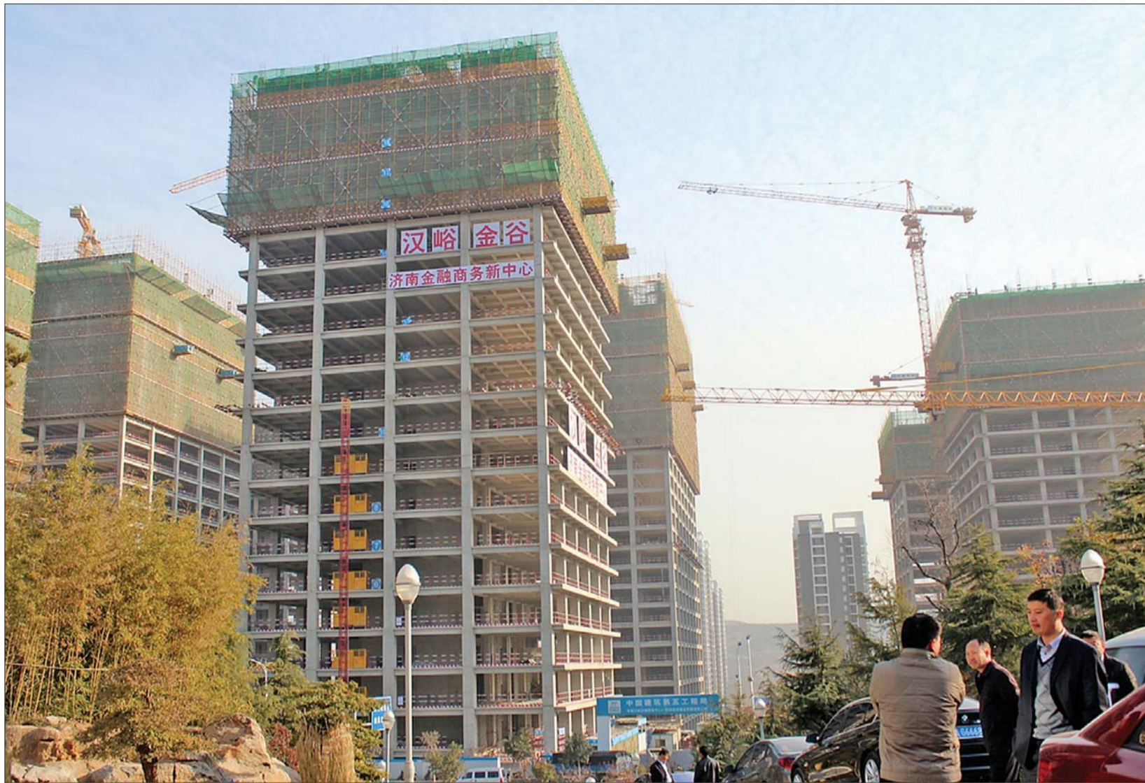
汉峪金谷项目建筑工地。 本报记者 修从涛 摄
