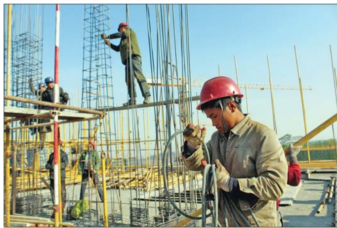
工人们在20层高的楼顶上进行作业。 本报记者 修从涛 摄
