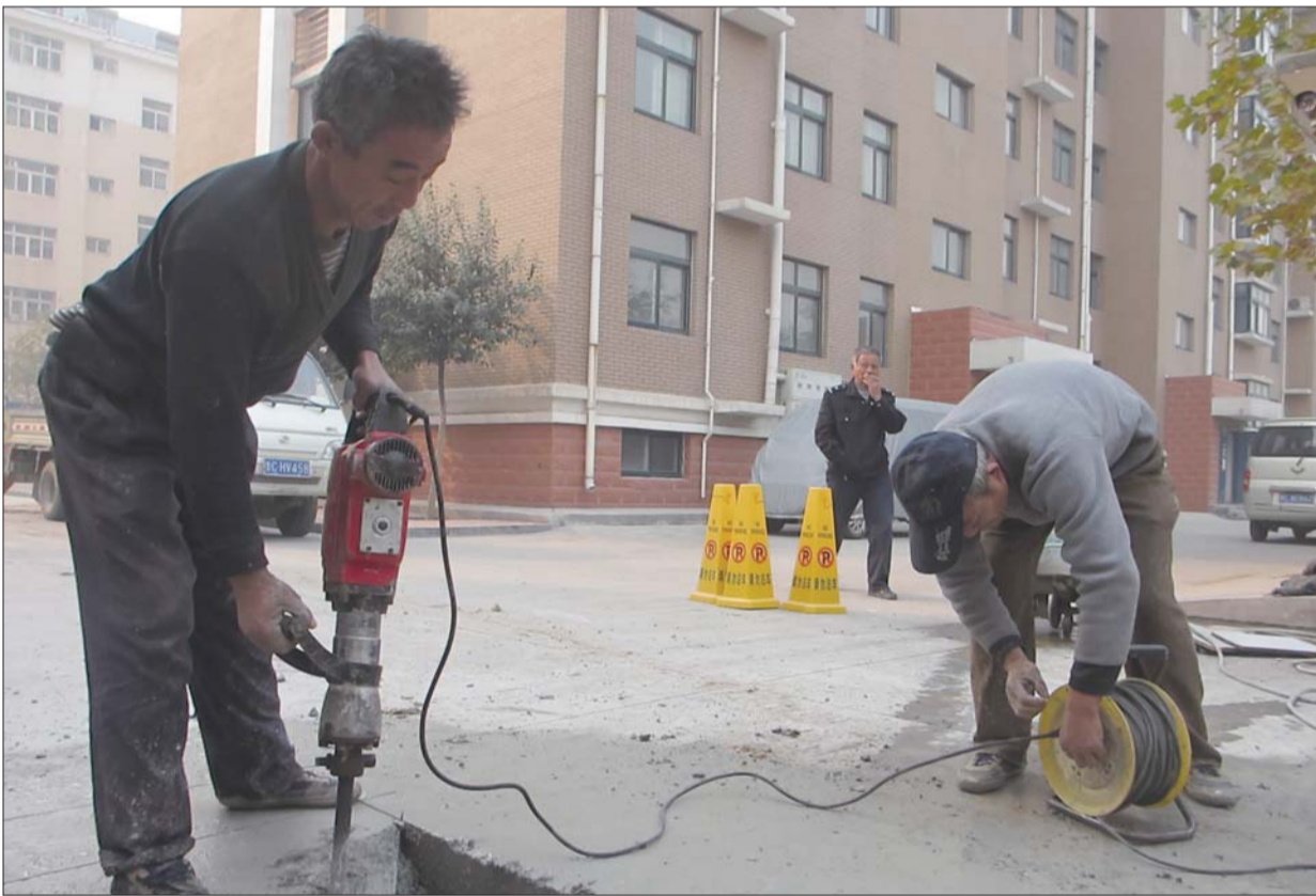
维修队抓紧排查漏点。 本报记者 张汝树 摄
