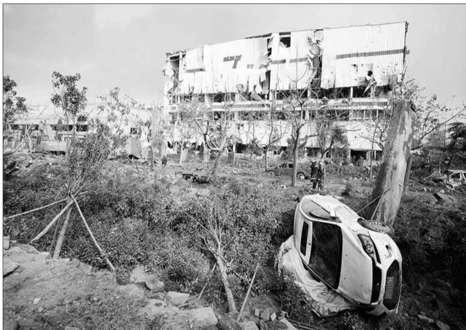
22日凌晨3时,青岛经济技术开发区中石化黄潍输油管线一输油管道发生原油泄漏。10时30分左右,在准备抢修过程中发生爆炸。图为事故现场。新华社发
