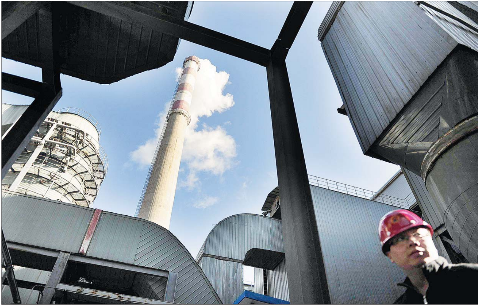
经过环保处理之后,热源厂烟囱里冒出来的基本上是水蒸汽。本报记者 王媛 摄
